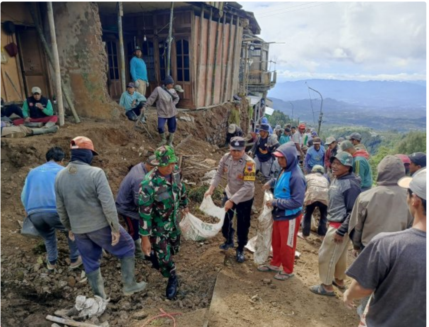
(Foto Dokumen) : Gotong royong pembersihan material longsor
